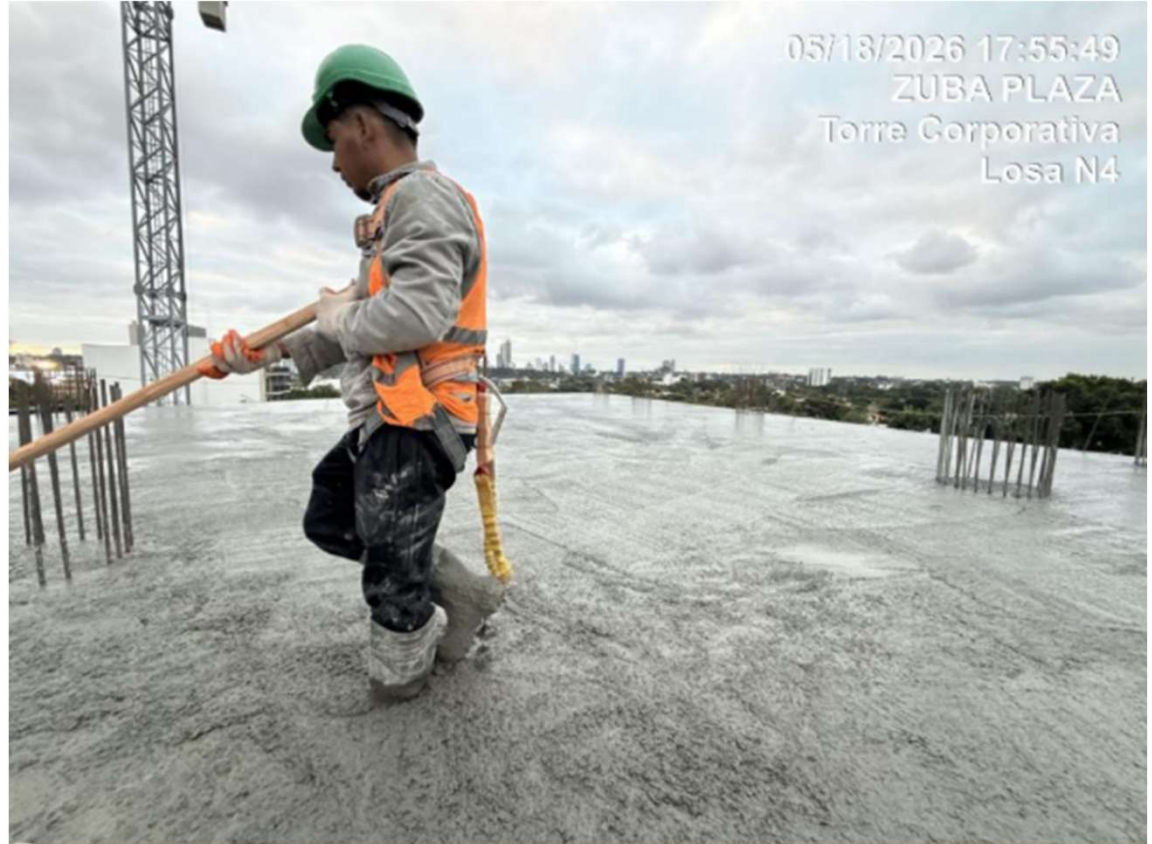
Cargamento de losa N4
